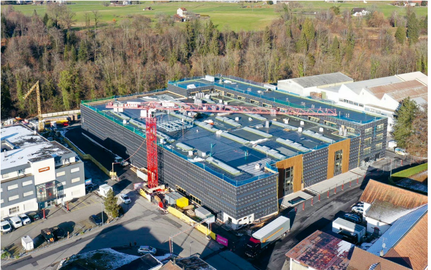
Neubau Trox Hesco Schweiz AG
