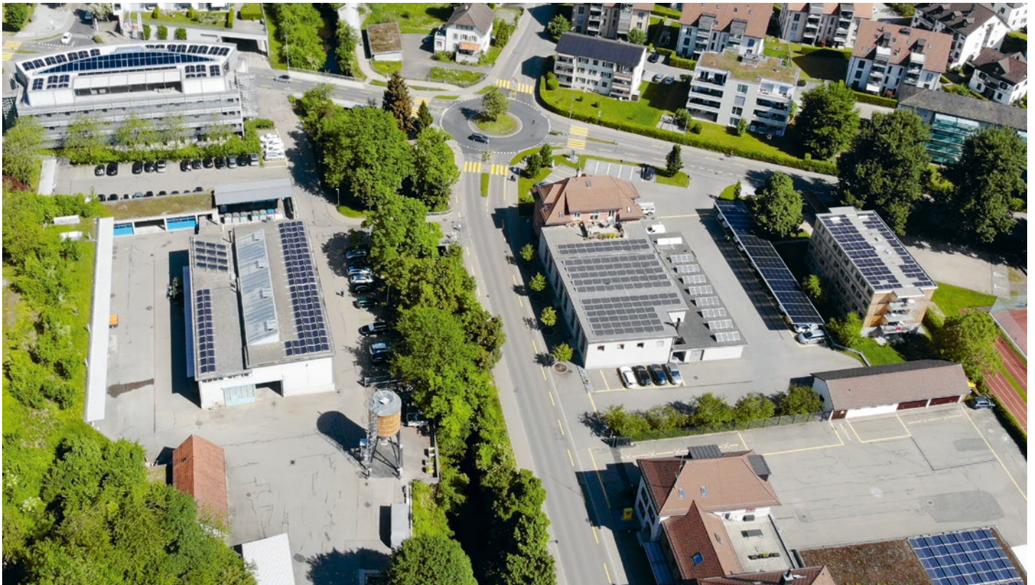
Die Gebäude, die der Gemeinde gehören, werden konsequent mit Photovoltaik-Anlagen ausgerüstet. Dies ist auf den Dächern auf diesem Bild gut zu sehen, von links nach rechts: Gemeindehaus, Werkhof, Gemeindewerke (GWR), Fahrzeugunterstand GWR, WohnWerk und Feuerwehr/GZ31. Zudem sind Schulhäuser, das Zentrum Breitenhof und das Polizeigebäude beim Amthausplatz mit Solarpanels zur Stromgewinnung eingedeckt.
