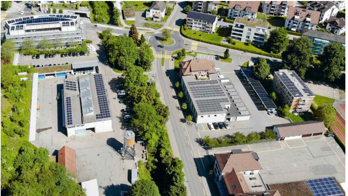
Die Gebäude, die der Gemeinde gehören, werden konsequent mit Photovoltaik-Anlagen ausgerüstet. Dies ist auf den Dächern auf diesem Bild gut zu sehen, von links nach rechts: Gemeindehaus, Werkhof, Gemeindewerke (GWR), Fahrzeugunterstand GWR, WohnWerk und Feuerwehr/GZ31. Zudem sind Schulhäuser, das Zentrum Breitenhof und das Polizeigebäude beim Amthausplatz mit Solarpanels zur Stromgewinnung eingedeckt.
