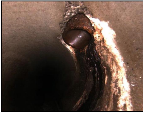
Bild: Anschluss unvollständig eingebunden
