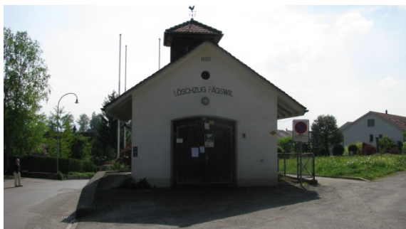
Aussenansichten vor der Sanierung
